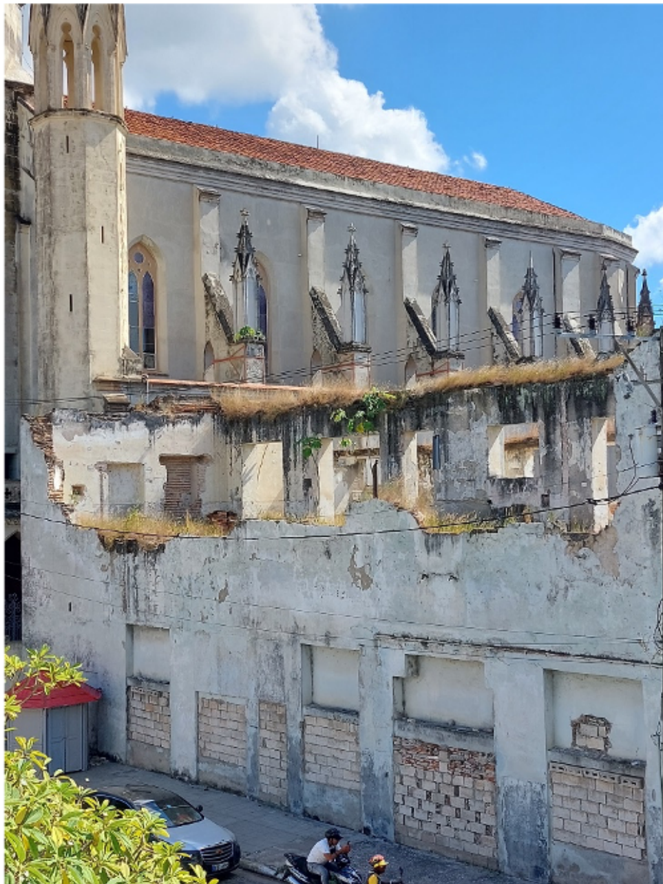
Vista de la fábrica desde los altos del Policlínico Centro (2022) / Imagen: Cortesía del autor.
