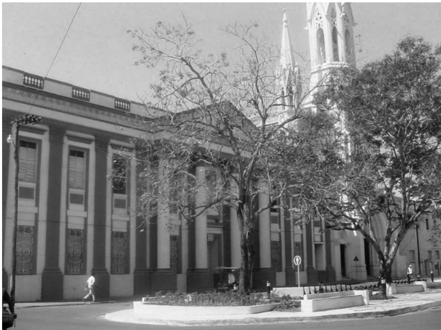
Fachada de las antiguas escuelas Pías, hoy centro educativo mixto Inés Luaces, después de la restauración de la iglesia en 2004 y la rehabilitación del parque Martí por la OHCC /Imagen: elcamaguey.org .
