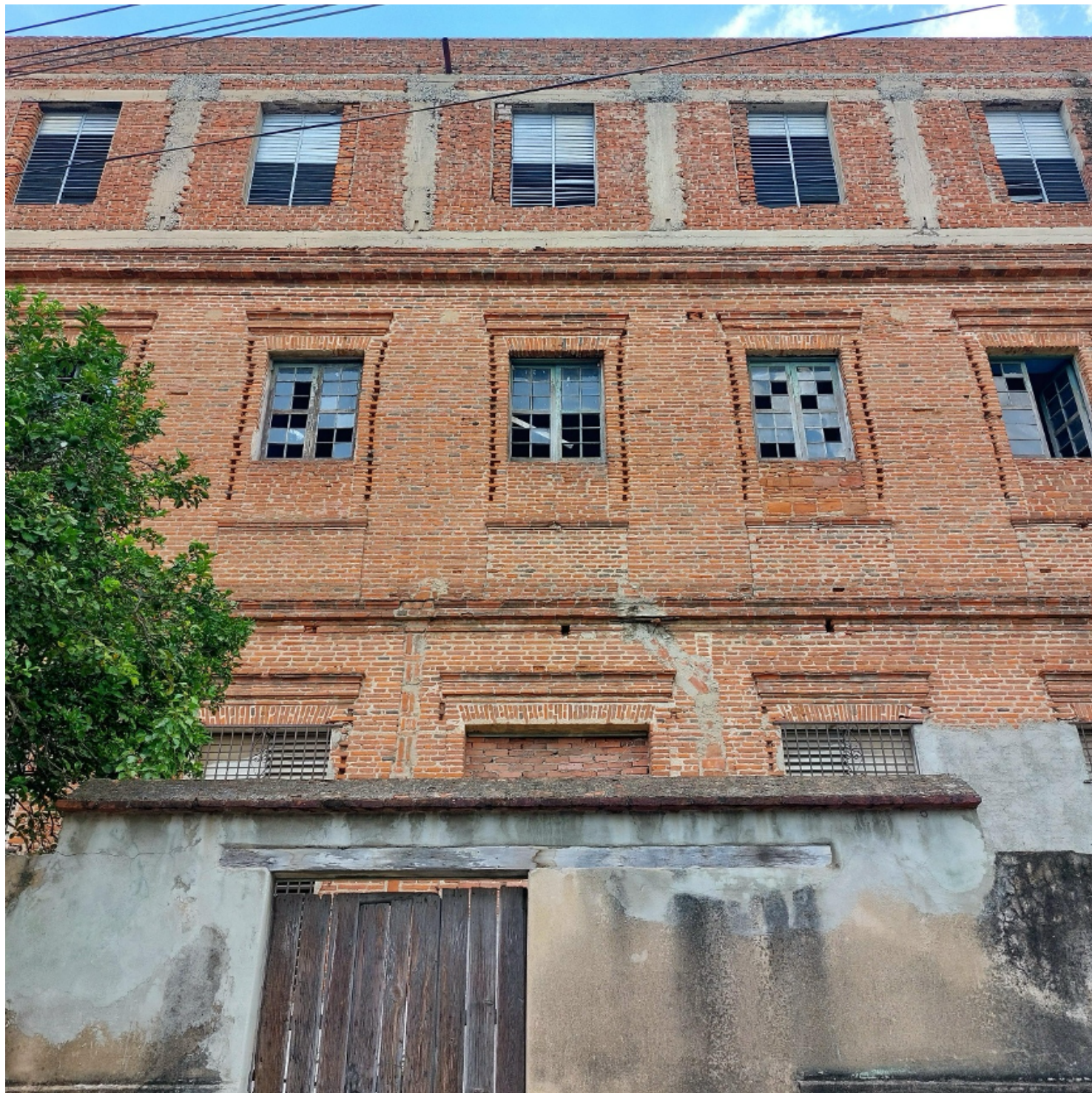
Fachada posterior de la escuela. Se aprecian los muros de ladrillo (2024) / Imagen: Cortesía del autor.
