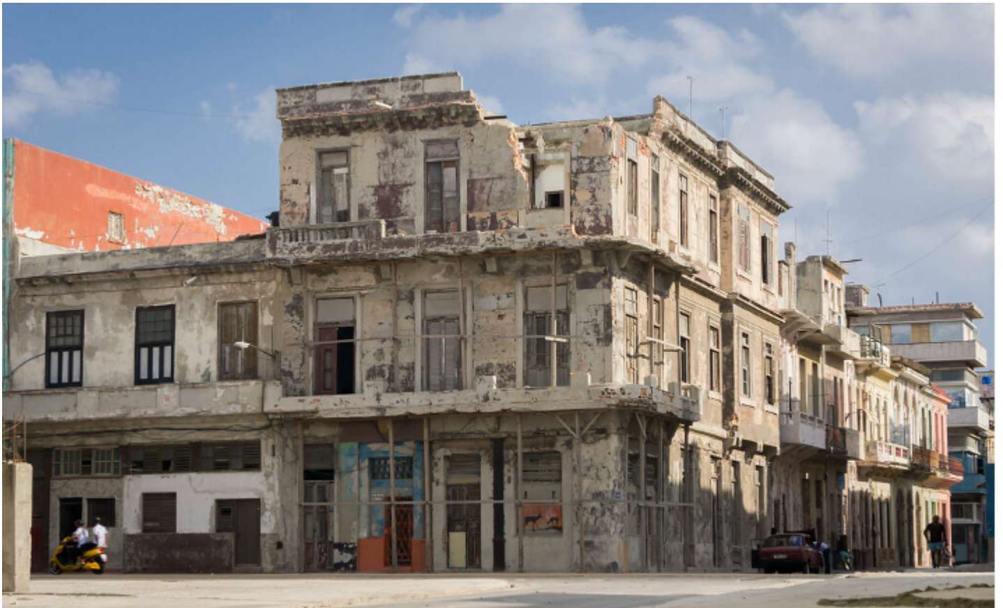
Edificio en deterioro en el sector del Malecón (2025). Fuente: MoNiZZy en Flickr.
