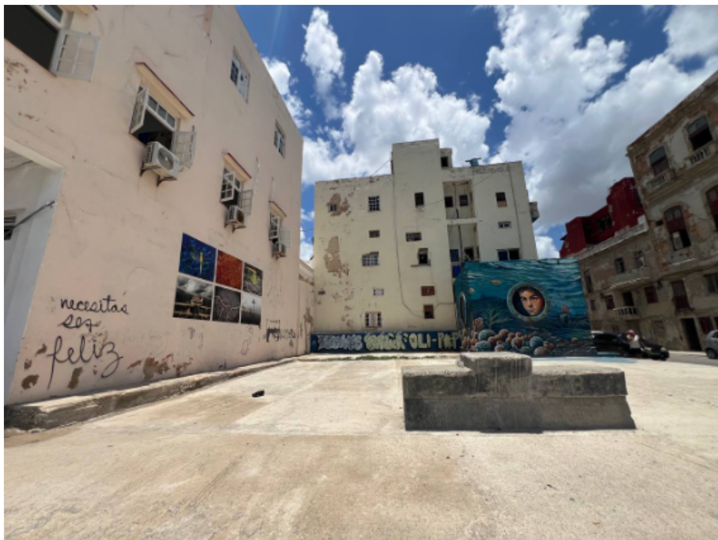
Parcela en licitación en el Malecón, tras derrumbe de estructura anterior (2025). Fuente: Archivo ODC.
