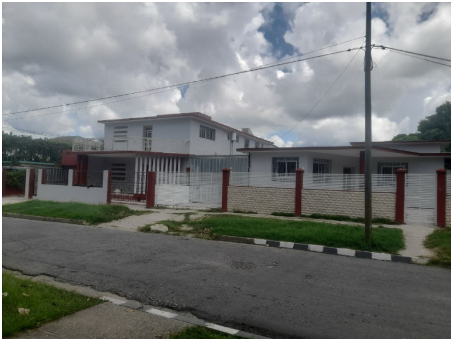
Exponente del movimiento moderno visiblemente intervenido en la fachada (2024) / Foto: Cortesía del autor.
